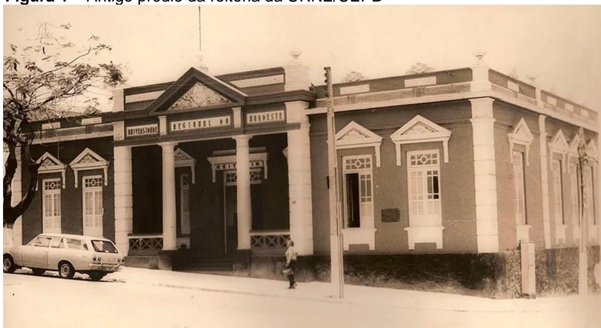
Figura 1 – Antigo prédio da reitoria da URNE/UEPB
