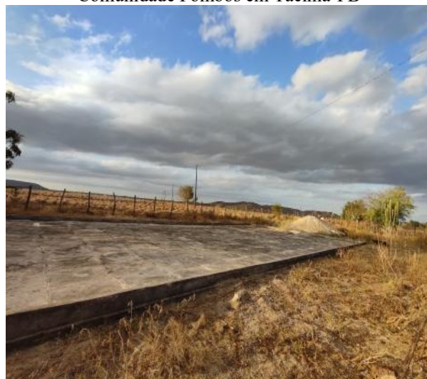
Imagem 3: Extensão da cisterna calçadão na Comunidade Pombos em Tacima-PB
