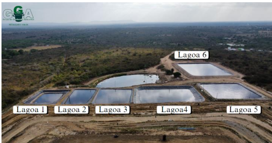
Figura 5- Lagoas de acumulação de lixiviado do aterro do semiárido paraibano
