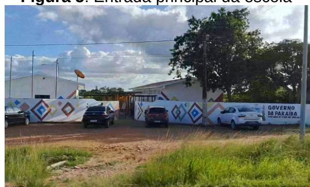
Figura 5: Entrada principal da escola
