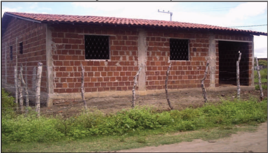
Figura 16 - Casa em construção
