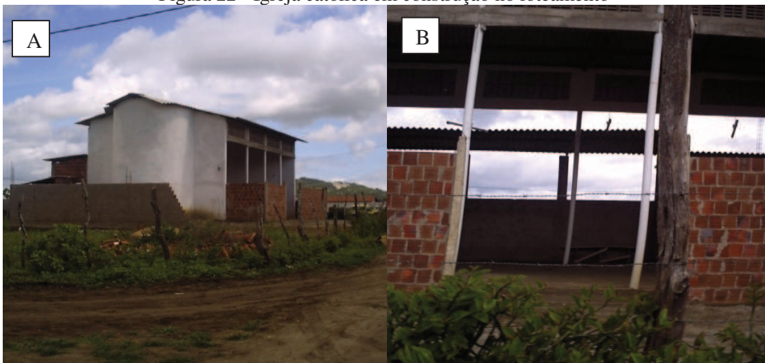
Figura 22 - Igreja católica em construção no loteamento
