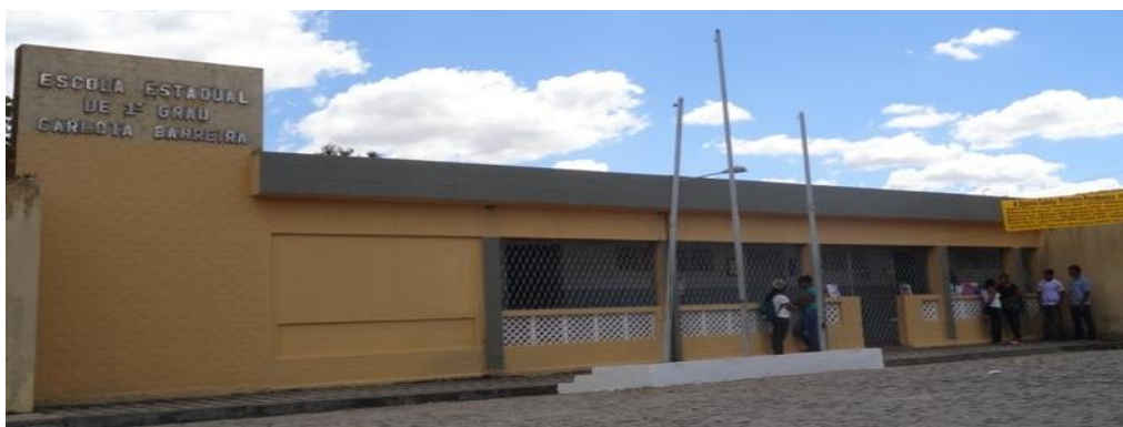
Foto 2: Fachada atual da Escola “Carlota Barreira”
