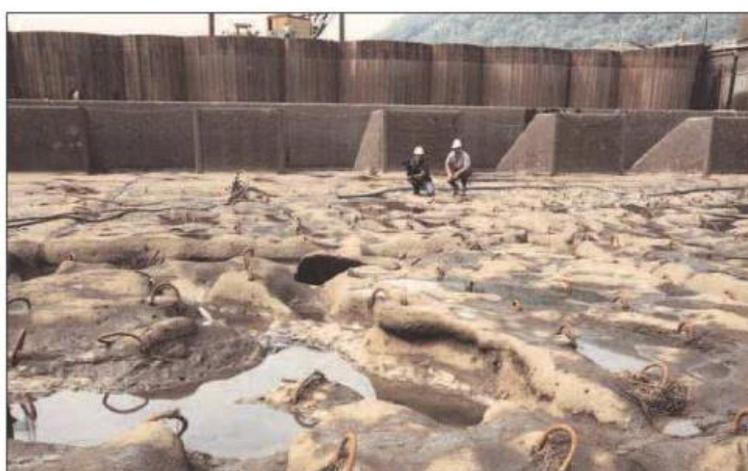
Figura 6 – Efeito da implosão das bolhas da cavitação em bacia de dissipação.
