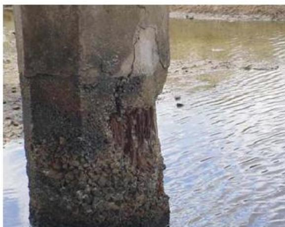
Figura 5 – Abrasão em pilar de ponte. Fonte: DNIT (2004)
