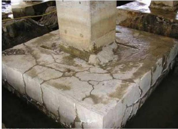
Figura 14 – Reação álcali-agregado em bloco de fundação.
