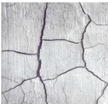
Figura 9 – Fissuração típica de retração térmica.
