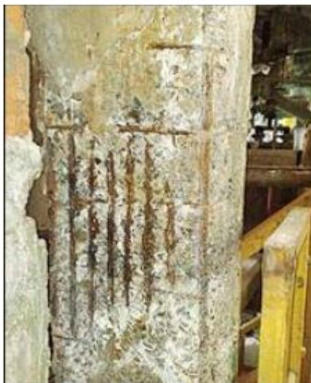
Figura 16 – Pilar com armadura exposta.
