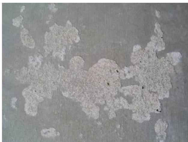
Figura 7 – Descamação do concreto ocasionado pela cristalização de sais nos poros.
