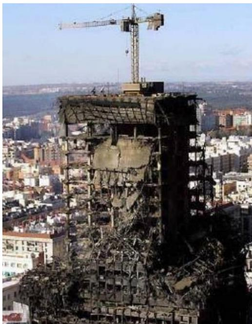
Figura 12 – Edifício na Espanha com sua estrutura de concreto armado degradada pela ação do fogo.
