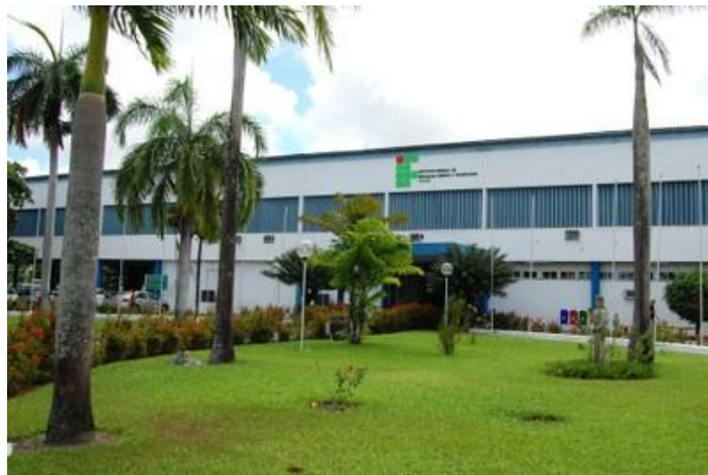
Figura 1 – Fachada do IFPB Campus I em João Pessoa-PB
