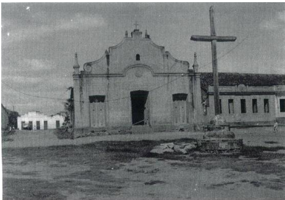
Figura 08 – Aspecto da capela de Santo Antonio, data indefinida. 3
