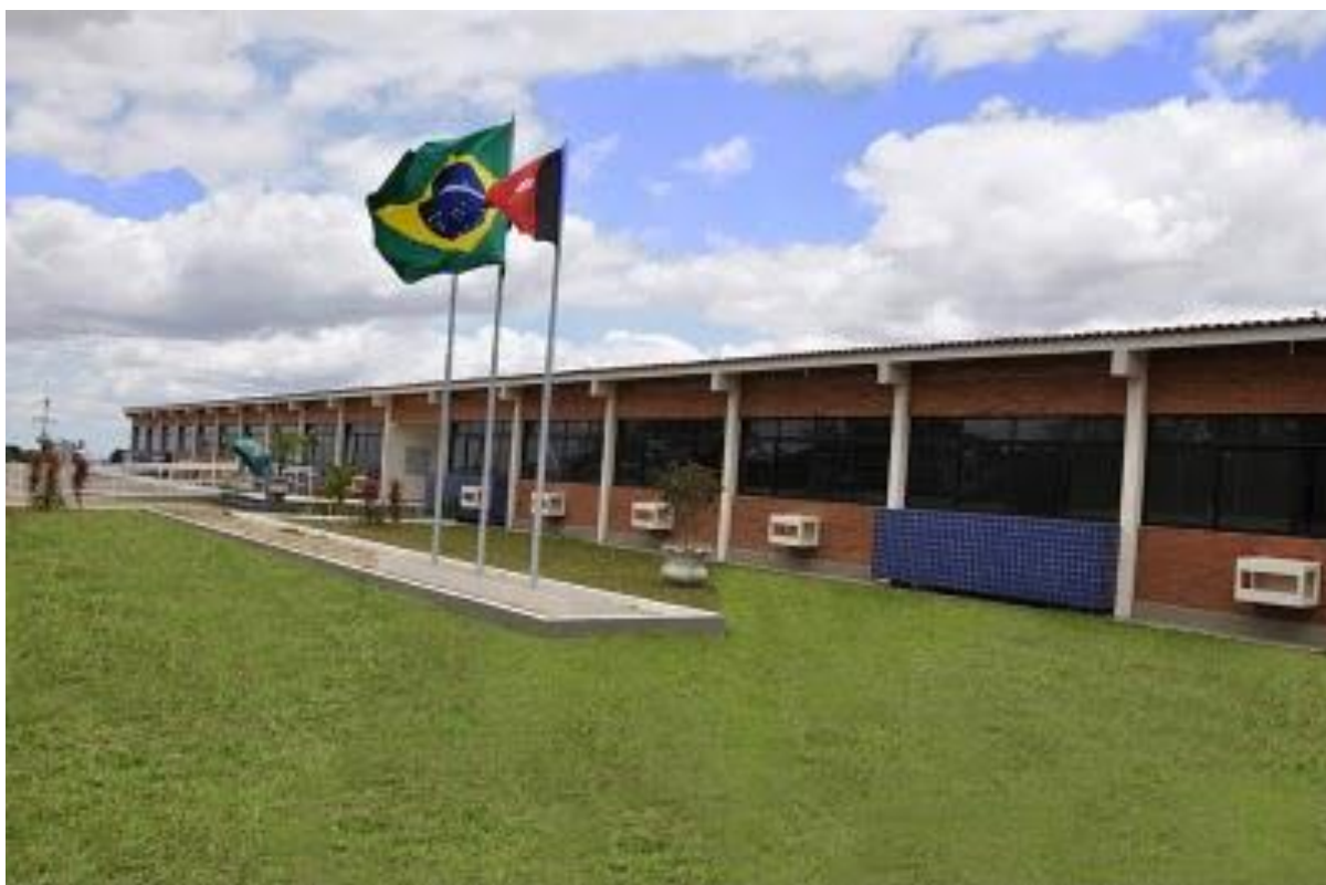
Figura 17 – Aspecto do Campus VIII, da Universidade Estadual da Paraíba em Araruna-PB.
