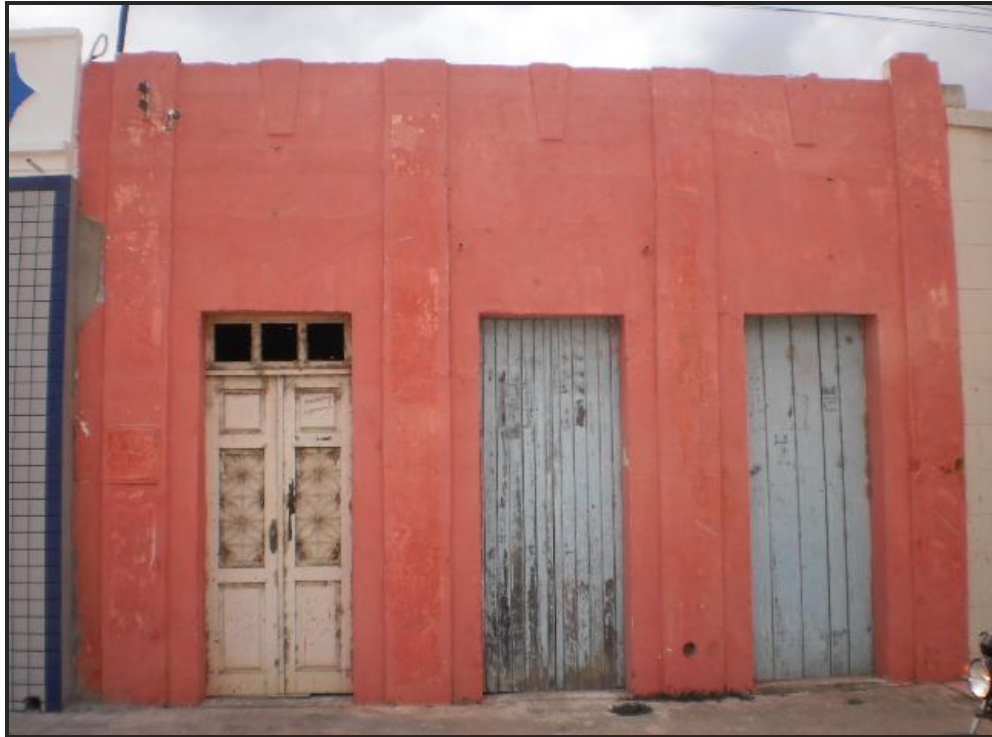
Figura 12 - Edificações antigas Fonte: Trabalho de campo
