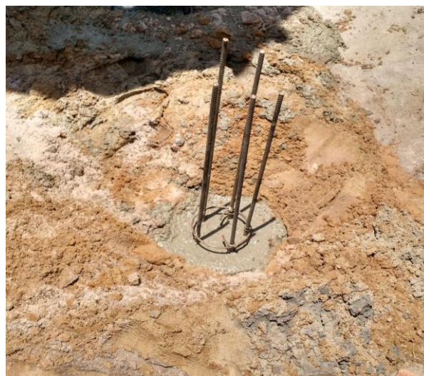
Figura 35 – Estaca finalizada 5 cm acima da cota de arrasamento de projeto Fonte: Registro de execução VDR
