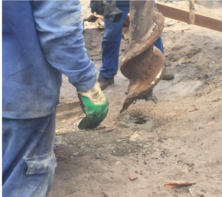
Figura 13 – Alinhamento da hélice com o piquete Fonte: Registro de execução do VDR.
