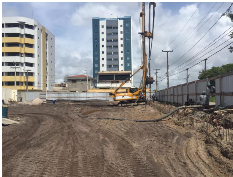
Figura 33 – Terreno escavado até a cota de arrasamento das estacas Fonte: Registro de execução VDR
