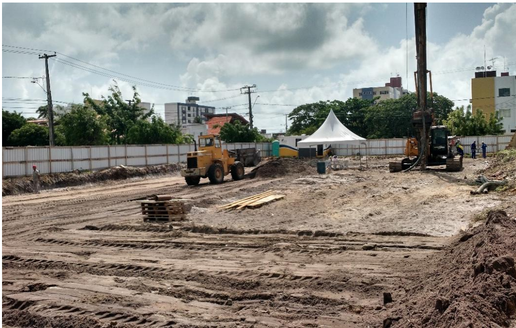
Figura 37 – Limpeza do terreno Fonte: Registro de execução VDR
