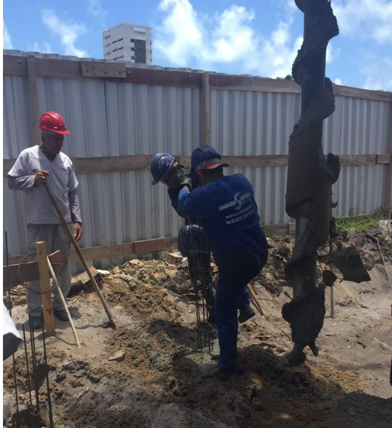
Figura 32 – Inserção da armação das estacas hélice contínua Fonte: Registro de execução VDR
