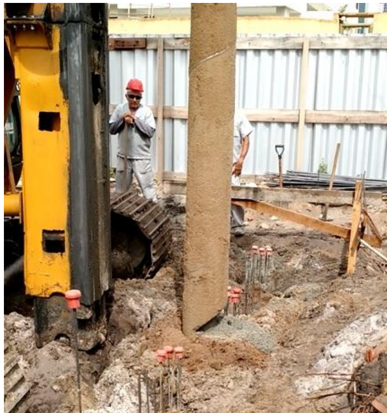
Figura 14 – Concretagem Fonte: Registro de execução do VDR.
