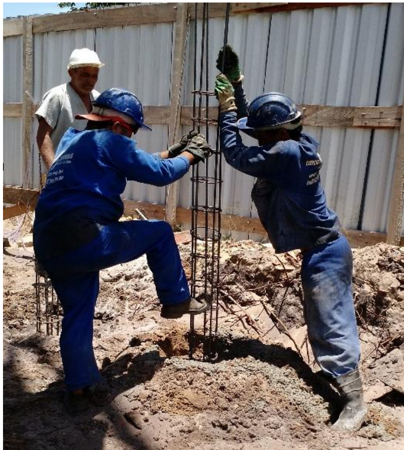
Figura 15 – Inserção da armadura Fonte: Registro de execução do VDR.
