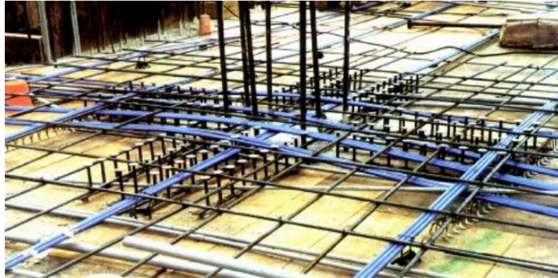
Figura 8a – Aplicação de conectores tipo pino
