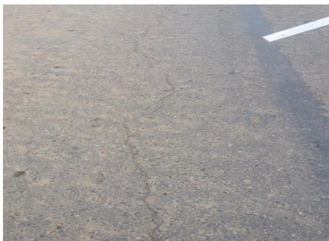
Figura 04: Trinca longitudinal
