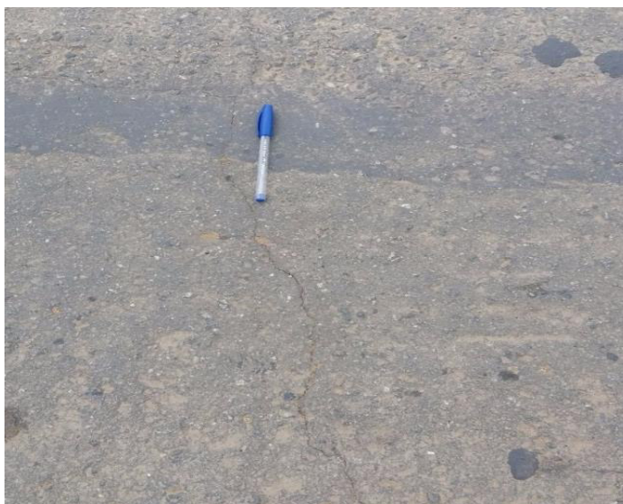
Figura 08: Trinca Transversal
