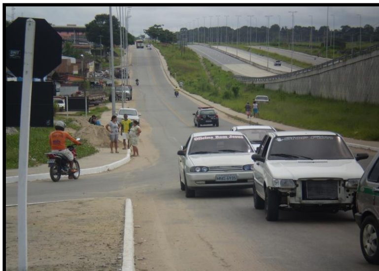
Figura 7: Deficiência no que se refere a travessia dos pedestres para o outro lado da via. Fonte: O Autor. Mamanguape, BR-101. Via lateral Oeste. Em: 06/06/2011.
