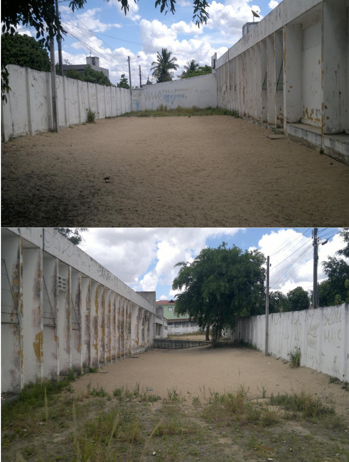
Figura 1 e 2 Espaço lateral interior utilizado para atividades física.
