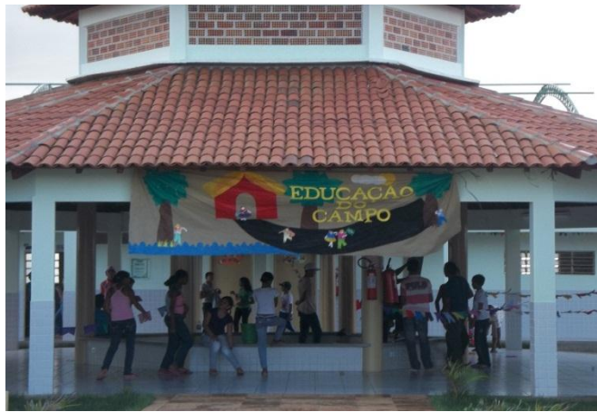
Figura 09- Vista parcial da área interna da Escola Tiradentes. Assentamento Tiradentes, Mari/PB.
