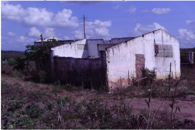
Figura 07- Galpão em ruínas onde funcionou a Escola Tiradentes no período inicial do acampamento. Mari/PB
