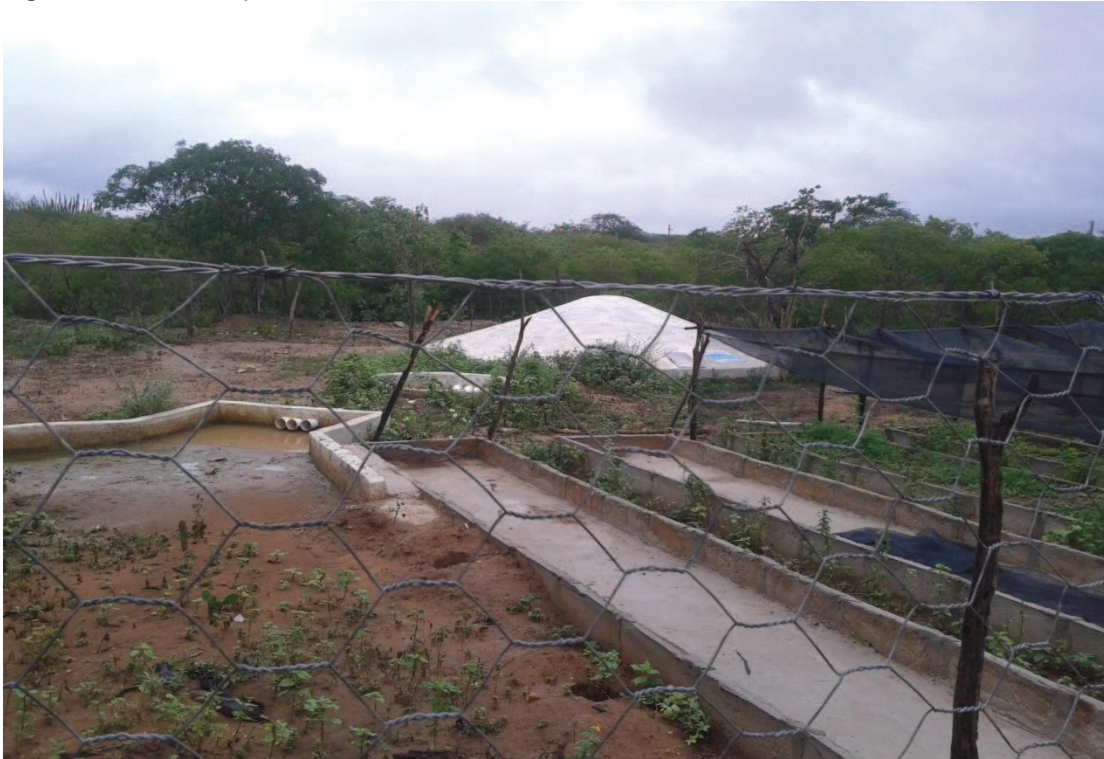
Figura 04: cisterna calçadão no assentamento Santa Tereza em Soledade-PB
