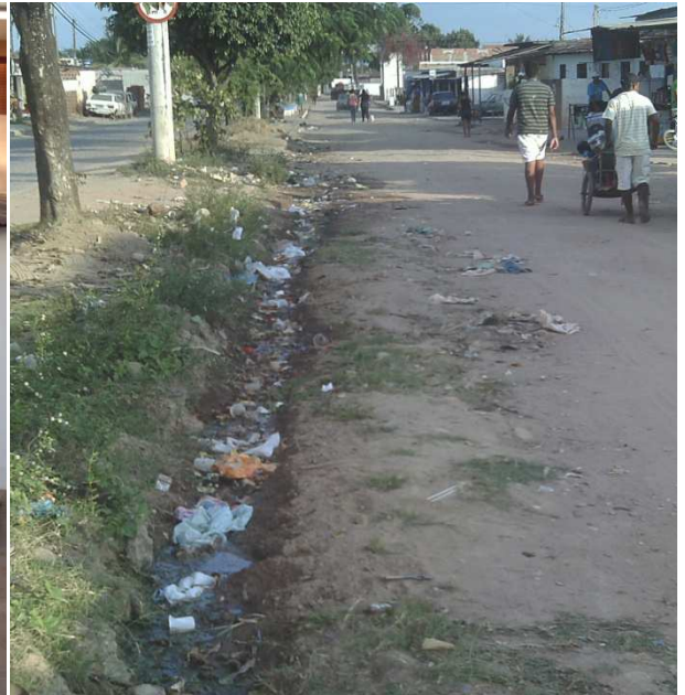
Figura: 2 Esgoto doméstico correndo a céu aberto, na Rua Cidade de Mari, loteamento Cidade Verde. Fonte: A autora, 2012.
