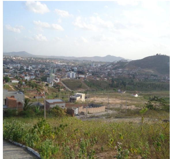
Figura 4: Loteamento: Edward Rocha, Guarabira/PB, casas em fase de construção. Fonte: Acervo da autora, 2012.
