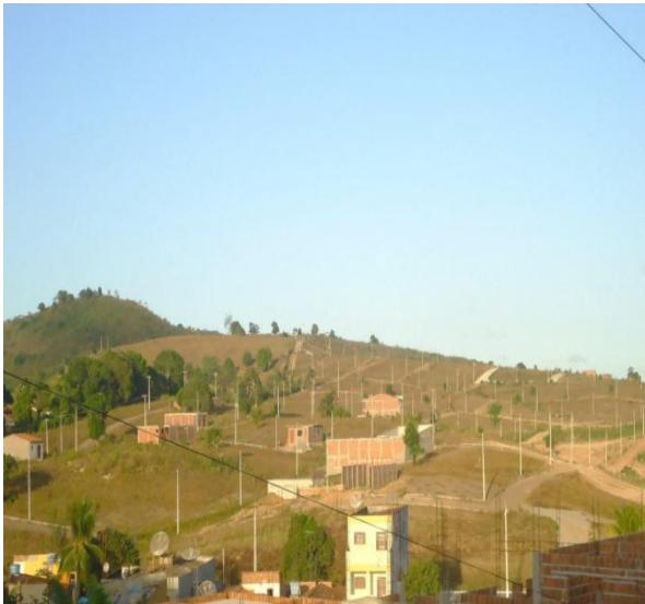
Figura 3: Loteamento: Monte das Oliveiras, Guarabira/PB, casas em fase de construção. Fonte: Acervo da autora, 2012.
