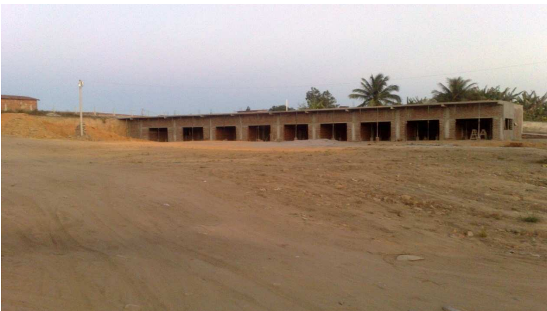
Fotografia 20 – Vista da área onde será construído um posto de gasolina Fonte: Ribeiro, Lenilson Felix. 2012.
