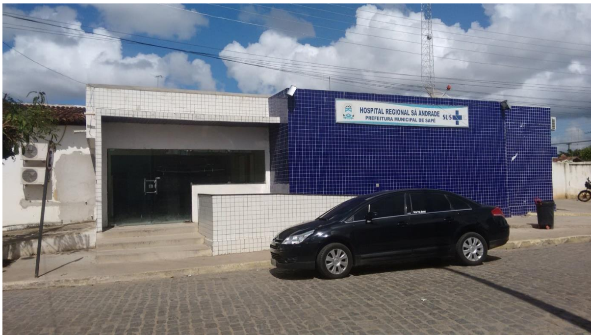
Foto 01 – Foto da fachada do Hospital Sá Andrade (Magno, julho de 2015).
