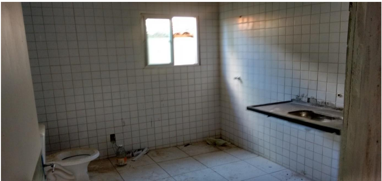
Foto 03 – Obras de reforma paradas no Hospital Sá Andrade (Magno, julho de 2015).
