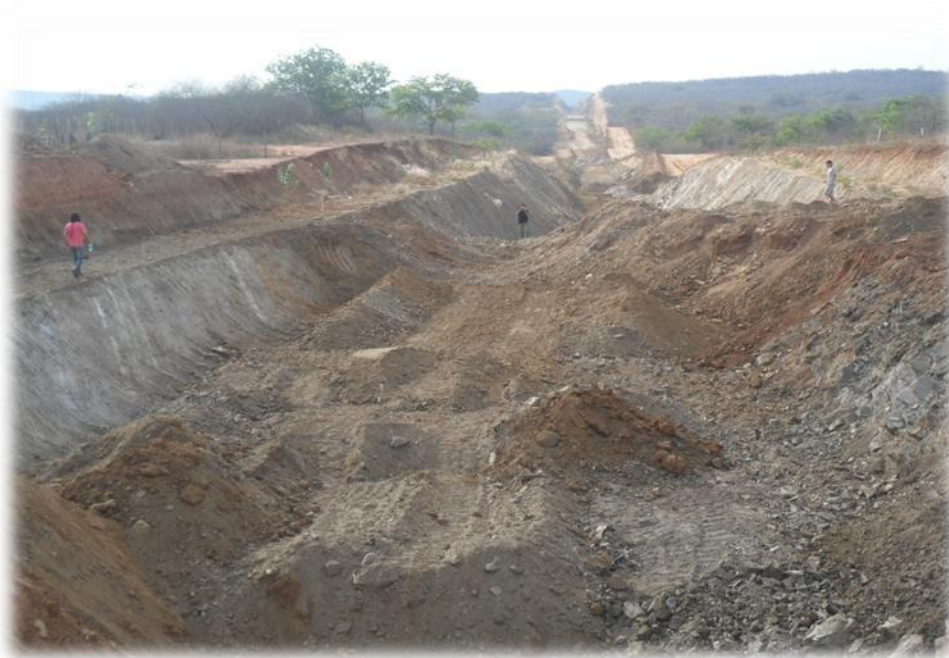
Fotografia 31: Construção da linha férrea Transnordestina. A fotografia anterior mostra o discurso ambiental do projeto em contrapartida à degradação causada pelas obras. Fonte: Trabalho de campo, 2011.
