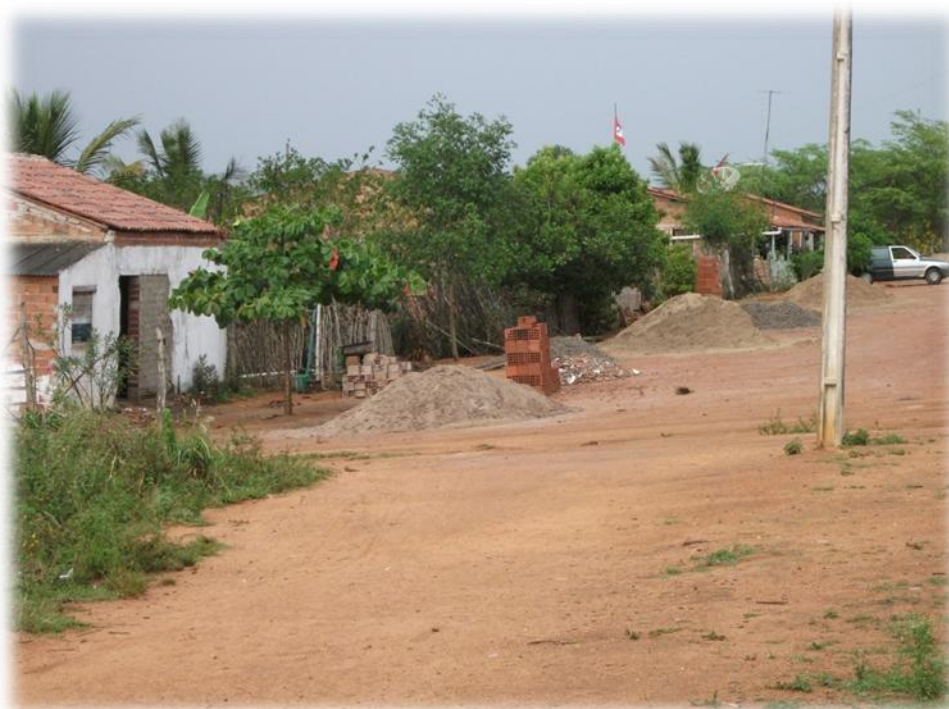
Fotografia 11: Assentamento Normandia em fase de construção. Caruaru/ PE. O momento inicial de um assentamento pode ser desestimulante. Daí a importância de programas e investimentos para desenvolvimentos desses territórios. Fonte: Trabalho de campo, 2011.
