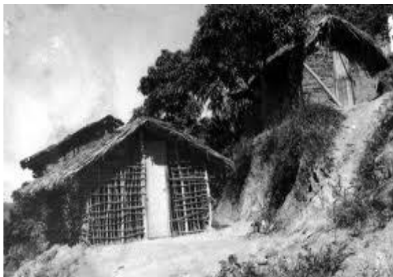
Foto 6: Casa de Taipa antigamente no Morro do Cruzeiro, Alagoa Grande/PB Fonte: Autor desconhecido, 1979.
