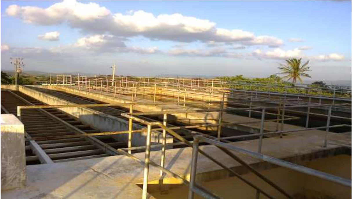
Fig.19 – Flocculador mecânico na ETA, Cacimba de Dentro – PB. Foto: Carlos Antonio de Lima, dez. 2013.
