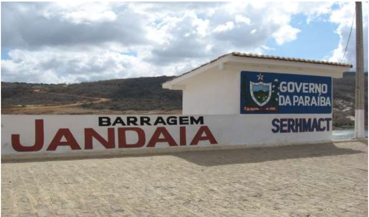
Fig. 23 – Barragem Jandaia, Bananeiras – PB. Foto: Carlos Antonio de Lima, dez. 2012.
