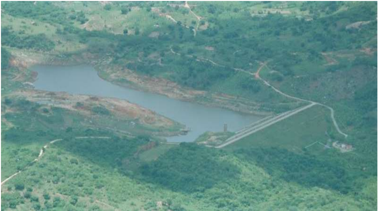
Fig. 15 – Vista aérea da Barragem de Canafístula II – Borborema-PB.
