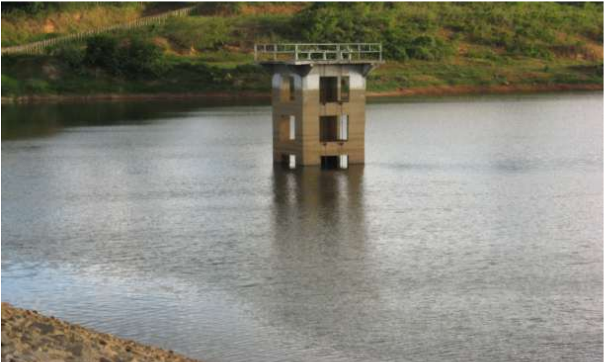
Fig. 17 – Barragem de Canafístula II – Borborema – PB Foto: Carlos Antonio de Lima, jun. 2010.
