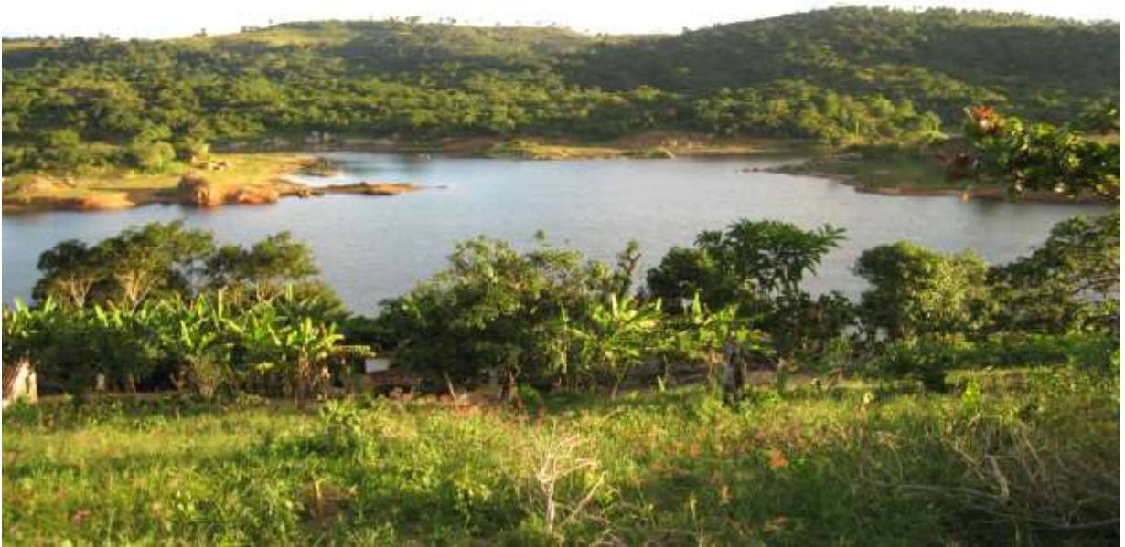
Fig. 16 – Barragem de Canafístula II – Borborema – PB Foto: Carlos Antonio de Lima, jun. 2010.
