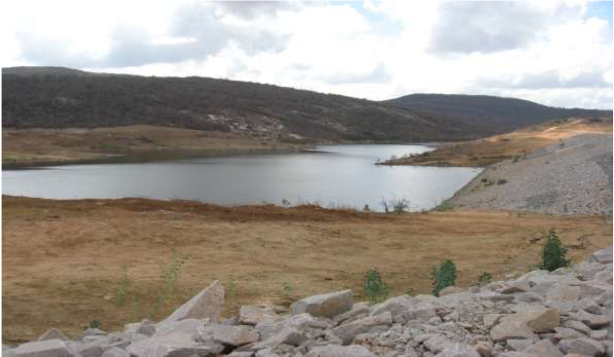
Fig. 22 – Barragem Jandaia, Bananeiras – PB. Foto: Carlos Antonio de Lima, dez. 2012.
