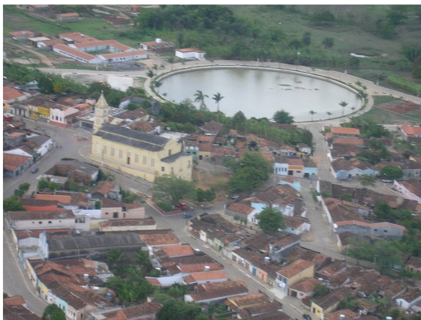
FOTO 01: Vista parcial da cidade de Alagoa Nova-PB.
