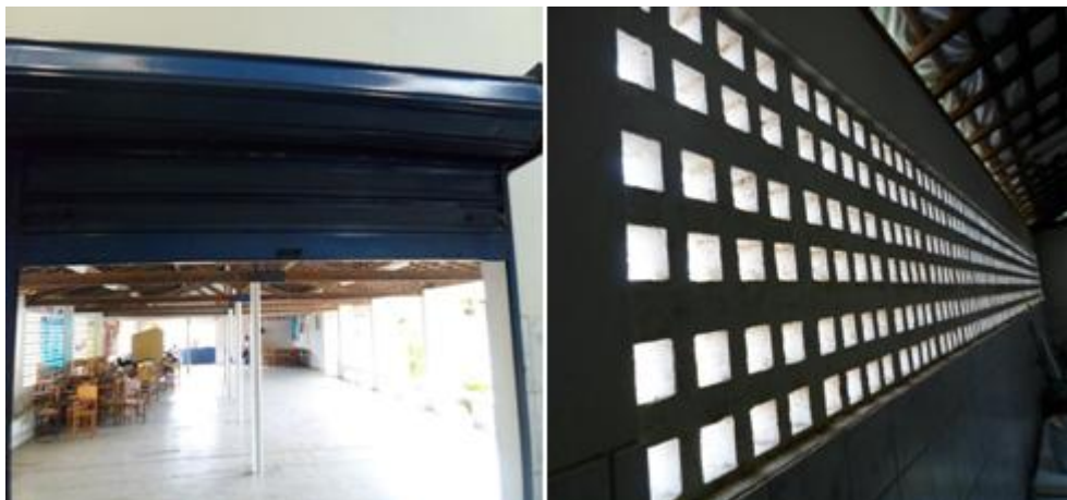
Figura 7 - Janelas e cobogós da cantina da Escola Municipal Papa João Paulo II.
