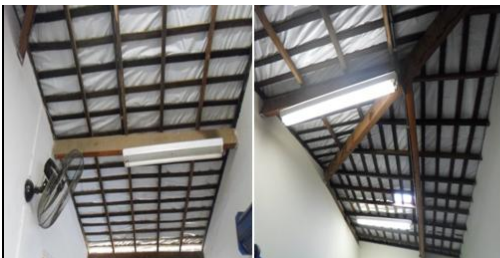
Figura 4 - Teto da cantina da Escola Municipal Papa João Paulo II.
