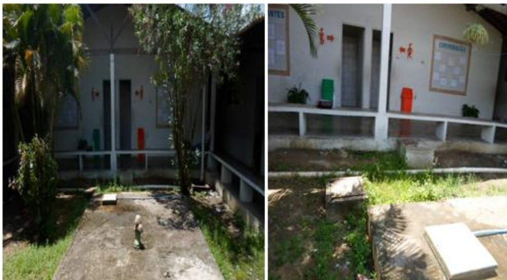
Figura 13 - Reservatório principal próximo a galerias de esgoto.
