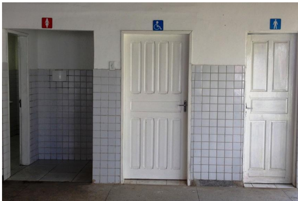
Foto 1: Banheiro adaptado para cadeirante da Escola Municipal Poeta Álvaro Guedes Pinheiro. Fonte: Trabalho de Campo
