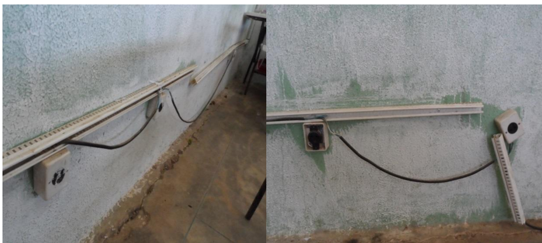
FOTO 4 – Estrutura das salas de aula.
