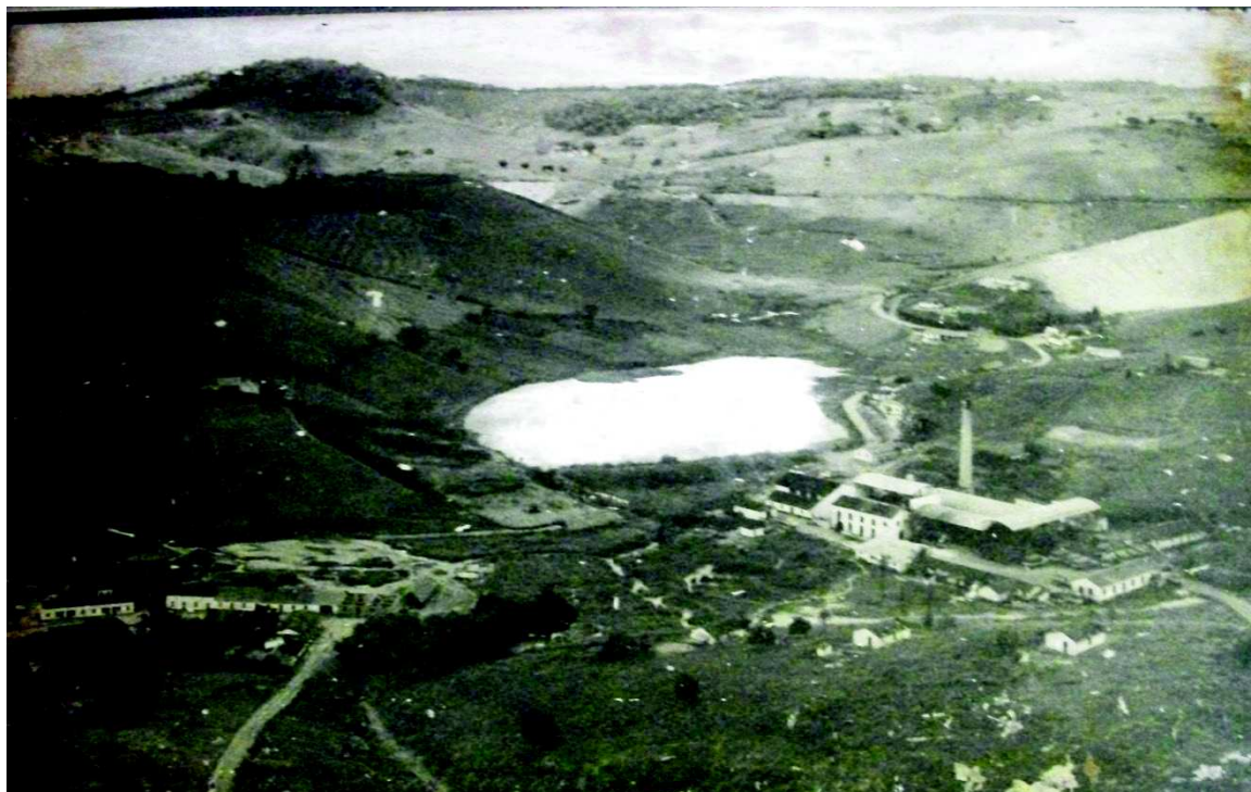
Figura 6: Prédio da Usina Santa Maria, meados dos anos 60 - FONTE: Acervo Particular
