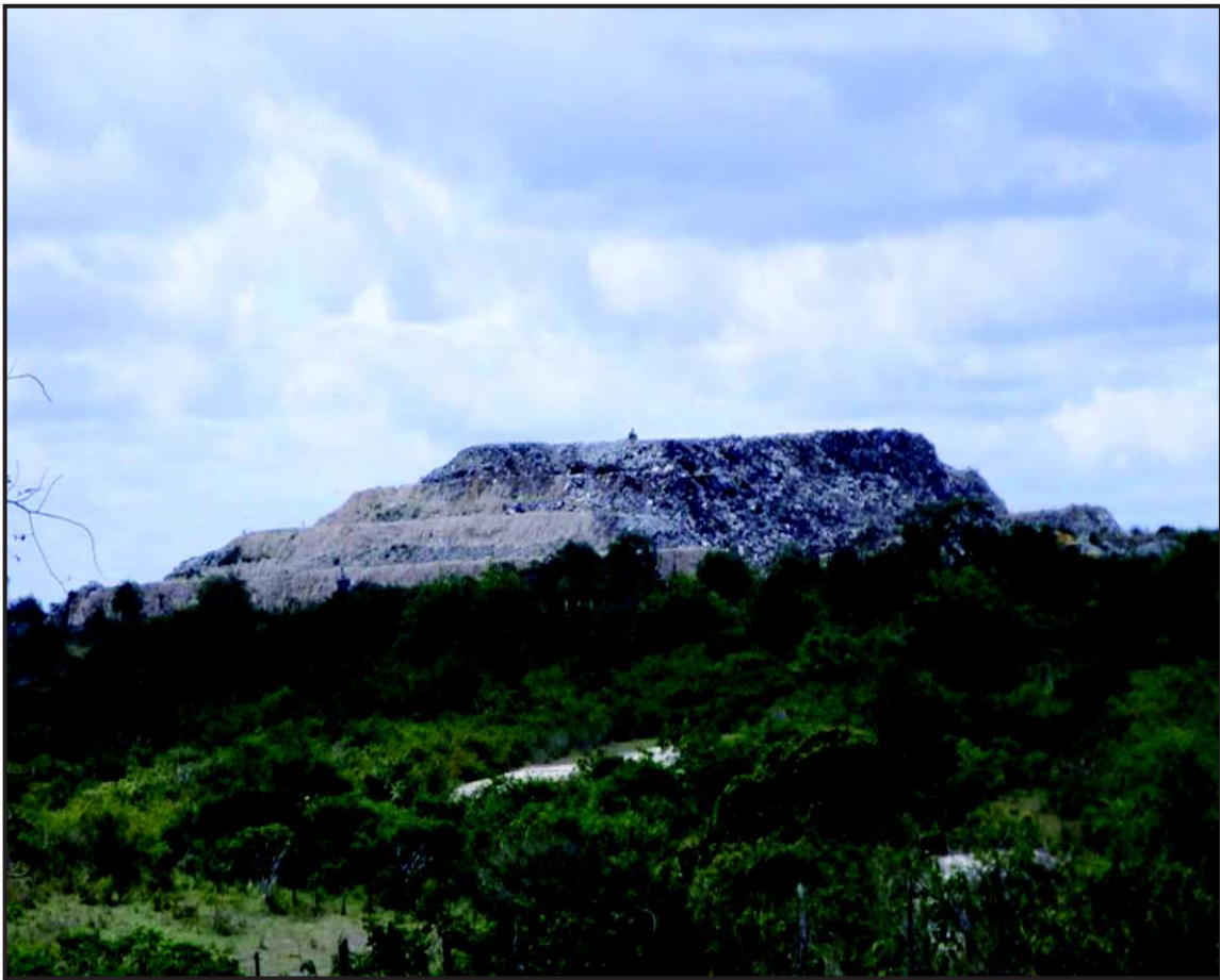
Figura 06: Imagem externa do aterro sanitário no município de Puxinanã – PB.
