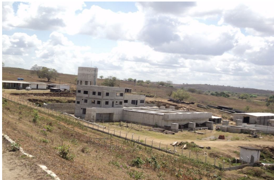
Foto 09: Visualização da adutora em construção desde 2003
