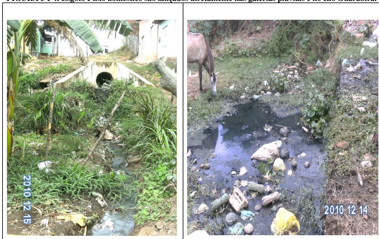
FIGURA 3 e 4: Esgoto e lixo doméstico são lançados diretamente nas galerias pluviais e no Rio Guarabira.
