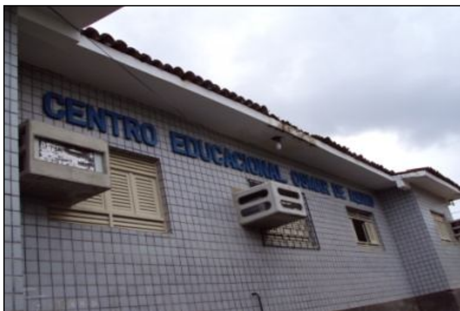
Foto 1 Fachada do Centro Educacional Osmar de Aquino Fonte: Patrícia Gomes, 2010.
