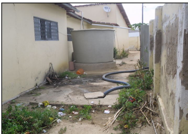
Foto 4 – Reservatório de água próximo a fossa séptica. Fonte: MELO, setembro/2010.
