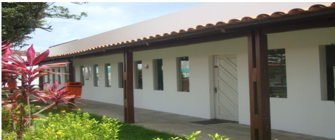
Figura 3: Fachada da frente do Arquivo do IPM-JP
