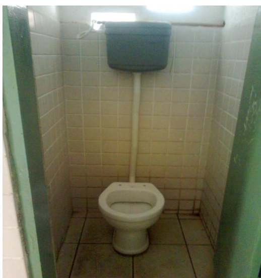
BANHEIRO DA ESCOLA
