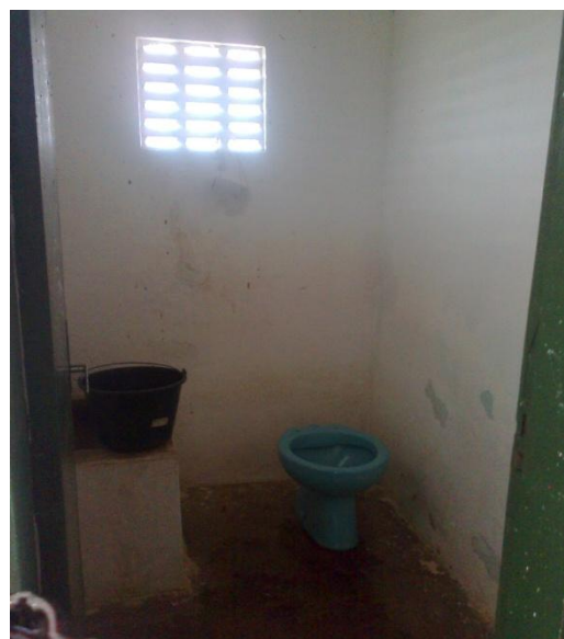
BANHEIRO DA ESCOLA
