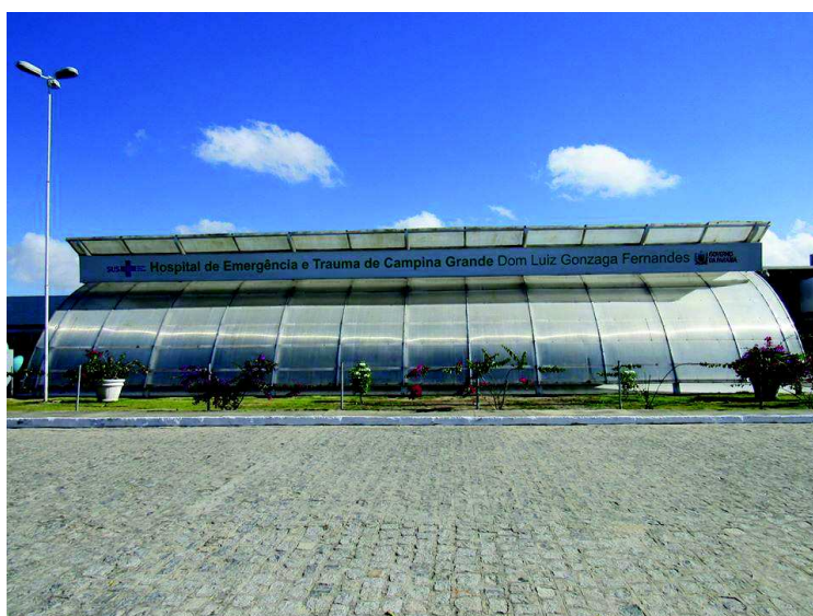
FIGURA 14: Fachada do Hospital de Trauma - 2016
