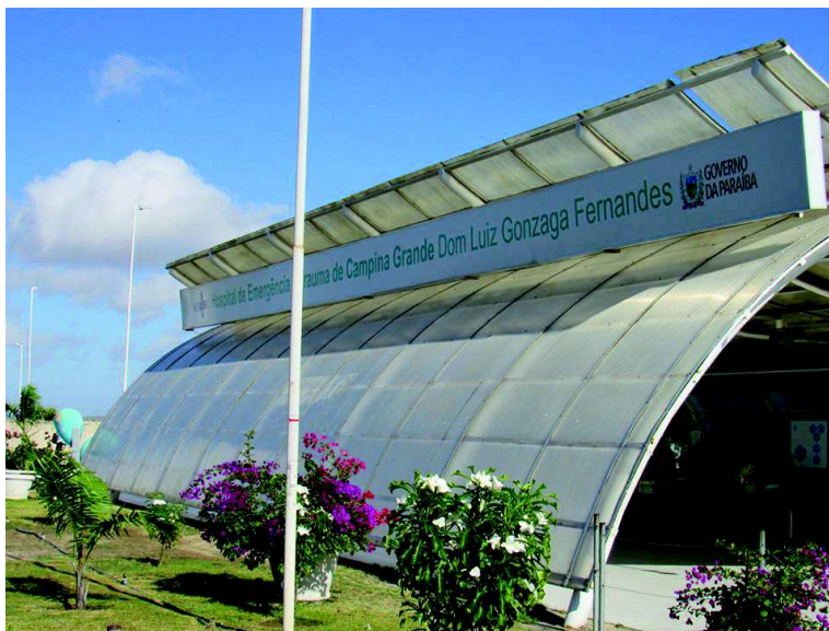
FIGURA 15: Fachada do Hospital de Trauma da lateral esquerda- 2016
