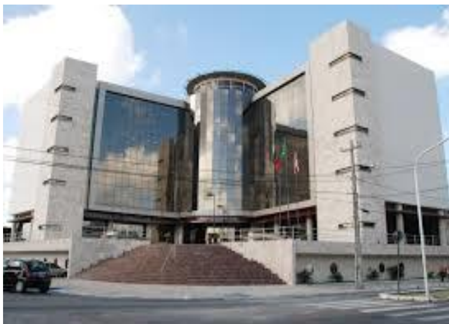
Figura 1 – Vista da Fachada do Fórum Criminal Comarca de João Pessoa.
