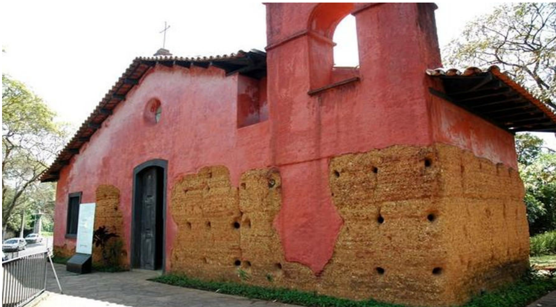
Figura 1 – Capela Morumbi, em São Paulo, construída em taipa-de-pilão, datada de 1825.
