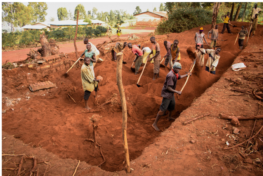
Figura 3 – Construção utilizando-se da terra do próprio local da obra (Muyinga, Burundi, 2012).
