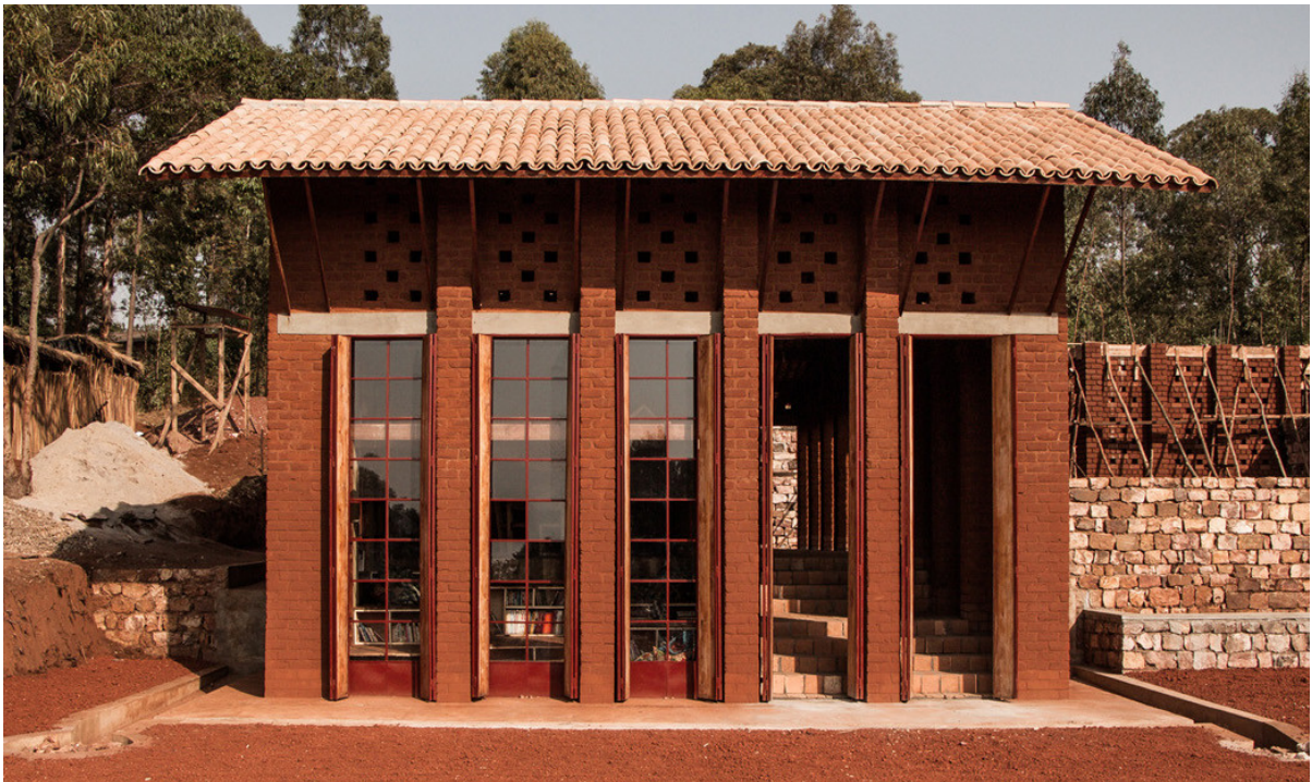
Figura 4 – Biblioteca de Muyinga, Burundi, construída em adobe e usando arquitetura atual (2012).
