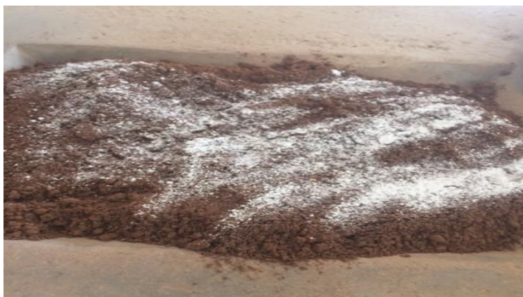
Figura 7 – Dosagem de cal hidratada.
