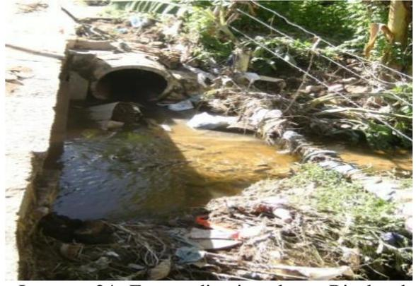
Imagem 24: Esgoto direcionado ao Riacho da Serra, D. Inês/PB, através da galeria pluvial.
