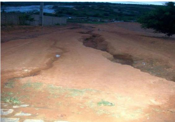
Imagem 25: Erosão causada pelas águas pluviais.
