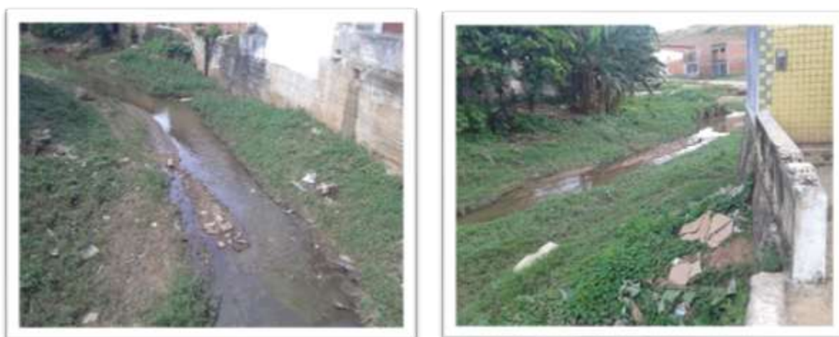
Figuras 06 e 07: Ocupação do rio Pilõezinhos dentro do perímetro urbano
