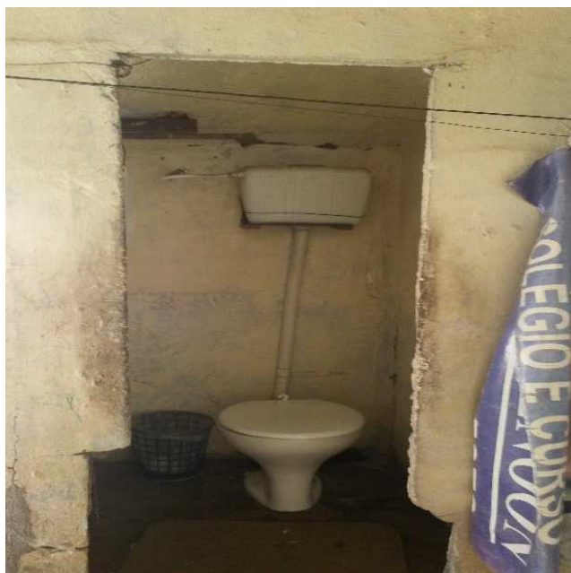
Figura 6: Banheiros após pequena reforma
