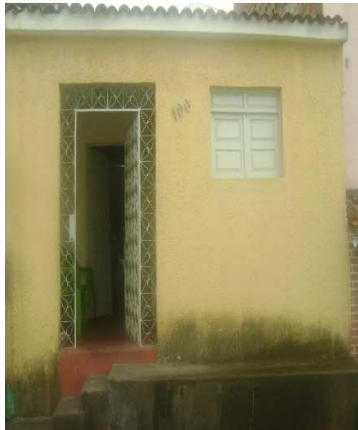
Figura 9: Antiga associação do Bairro Santa Terezinha, construída pelo antigo presidente junto com os moradores.
