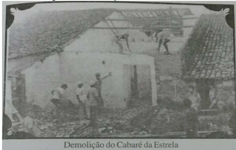
Figura 17: Demolição do Cabaré Estrela.
