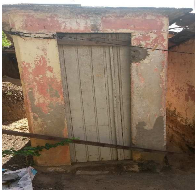
Figura 5: Banheiros cedidos pelo SESP, feitos de placas e concreto.
