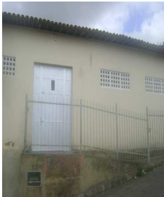
Figura 24: Antigo prédio onde funcionava a creche, localizado na Rua Bráulio Martins.
