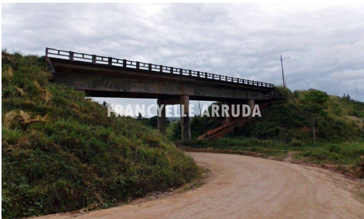
Figura 30- Ponte Escritor José Lins do Rego- parte inferior.
