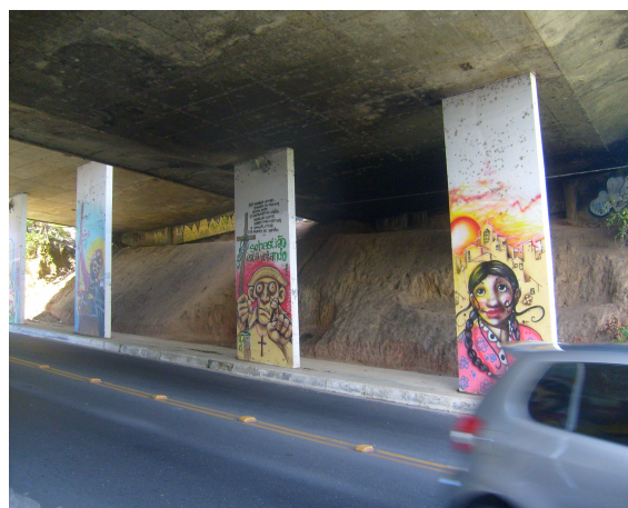
FIGURA 4- Viaduto sobre encosta íngreme Fonte: Paulo Gregório, 2008.
