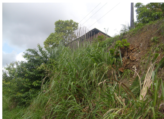
FIGURA 6 -Habitação à beira do talude Fonte: Paulo Gregório, 2008.
