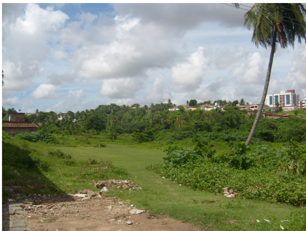
FIGURA 10 -Área com grau de risco baixo devido ao relevo e cobertura vegetal. Fonte: Paulo Gregório, 2008.
