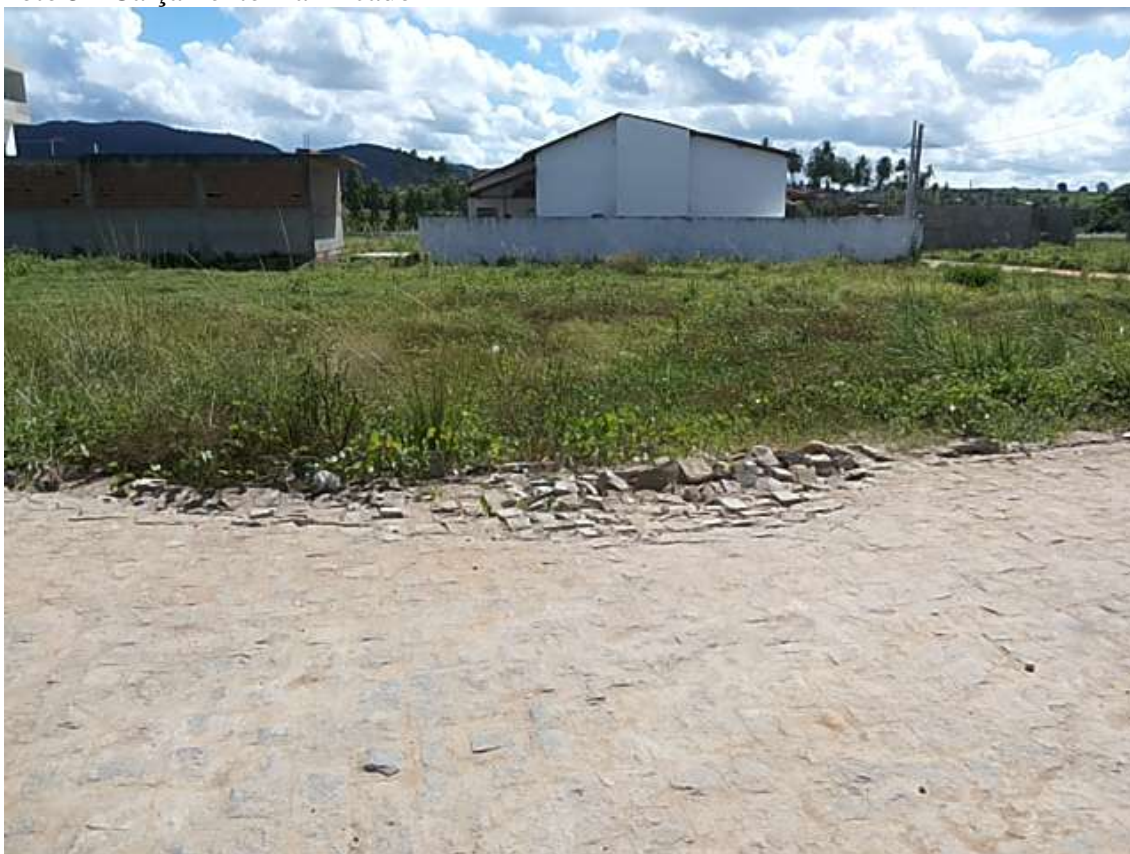
Foto 5 - Calçamento Danificado
