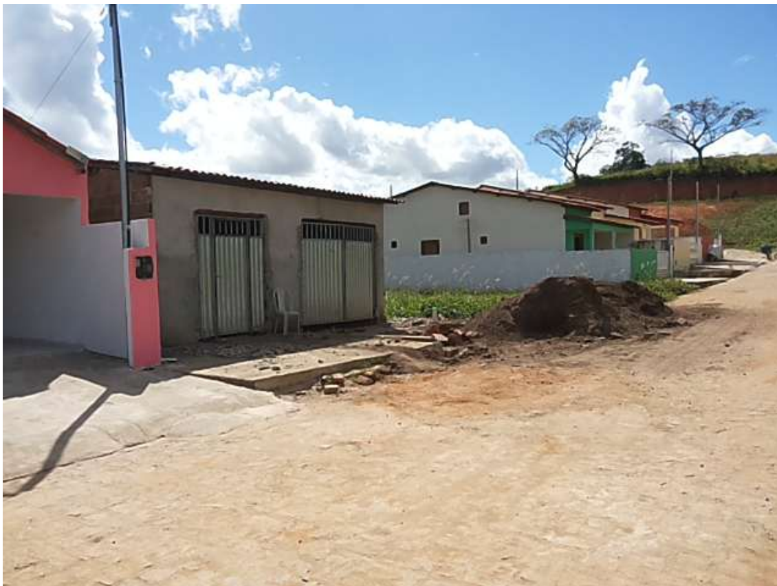
Foto 1 - Residências com obras concluídas e inacabadas
