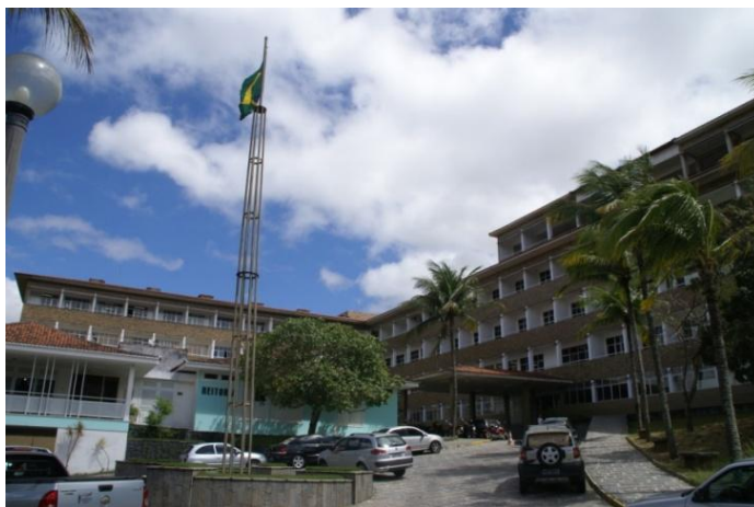
Figura 04 – Fachada Principal do prédio da Administração Central da UEPB onde está localizada a Livraria da UEPB.
