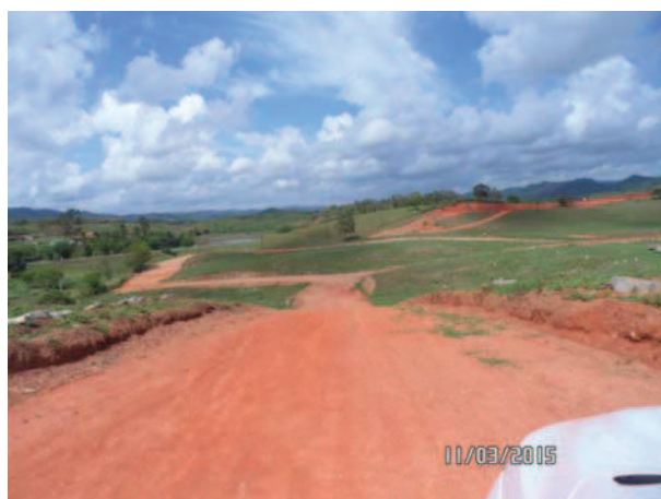
Fig.14 e 15: Fotos demonstrando a execução das obras de infraestrutura básica: abertura e pavimentação das vias de circulação e implantação de meio-fio do loteamento. (Fotos: Isabela Bezerra da Costa Paiva, 2015).
