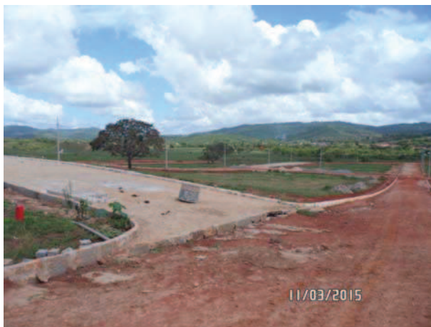
Fig.14 e 15: Fotos demonstrando a execução das obras de infraestrutura básica: abertura e pavimentação das vias de circulação e implantação de meio-fio do loteamento. (Fotos: Isabela Bezerra da Costa Paiva, 2015).
