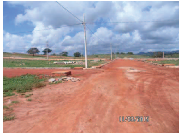
Fig.10 e 11: Fotos demonstrando a execução das obras de infraestrutura básica: limpeza do terreno, abertura de vias de circulação e implantação de meio-fio do loteamento. (Fotos: Isabela Bezerra da Costa Paiva, 2015).
