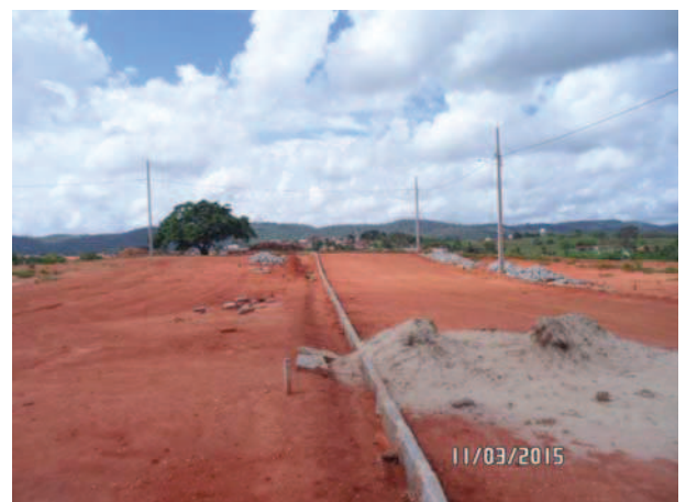
Fig.14 e 15: Fotos demonstrando a execução das obras de infraestrutura básica: abertura e pavimentação das vias de circulação e implantação de meio-fio do loteamento. (Fotos: Isabela Bezerra da Costa Paiva, 2015).
