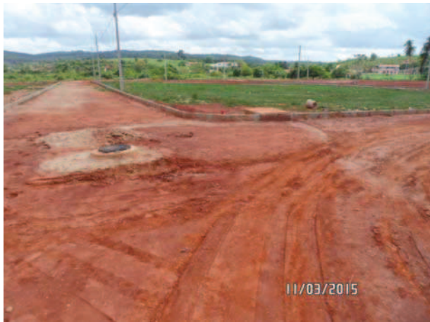
Fig.12 e 13: Fotos demonstrando a execução das obras de infraestrutura básica: abertura das vias de circulação, implantação de meio-fio, soluções para a drenagem pluvial com a implantação dos poços de visita e implantação dos postes e transformadores para a distribuição da energia elétrica do loteamento. (Fotos: Isabela Bezerra da Costa Paiva, 2015).
