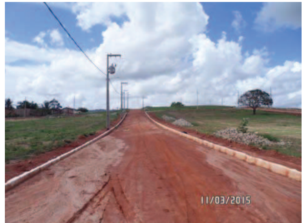
Fig.12 e 13: Fotos demonstrando a execução das obras de infraestrutura básica: abertura das vias de circulação, implantação de meio-fio, soluções para a drenagem pluvial com a implantação dos poços de visita e implantação dos postes e transformadores para a distribuição da energia elétrica do loteamento. (Fotos: Isabela Bezerra da Costa Paiva, 2015).
