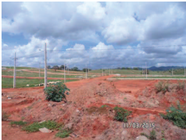
Fig.10 e 11: Fotos demonstrando a execução das obras de infraestrutura básica: limpeza do terreno, abertura de vias de circulação e implantação de meio-fio do loteamento. (Fotos: Isabela Bezerra da Costa Paiva, 2015).
