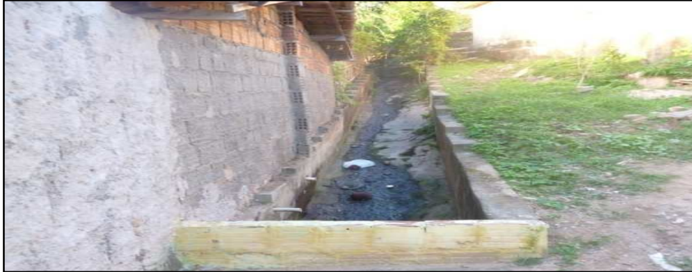
Figura 16: construção improvisada para escoamento de dejetos
