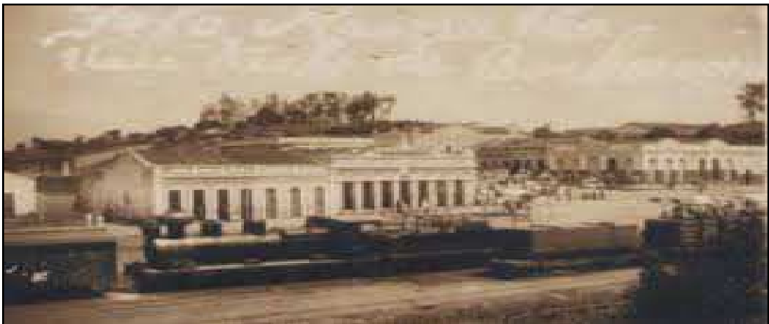
Figura 05: linha férrea de Borborema PB
