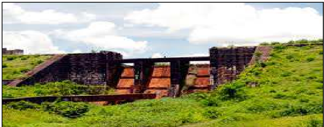
Figura 02: ruínas da antiga hidroelétrica
