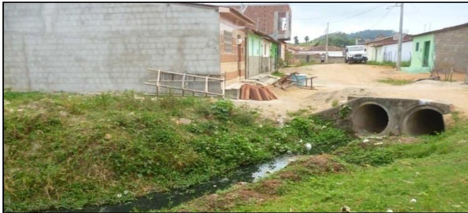
Figura 17: lançamento de esgoto em córrego no conjunto
