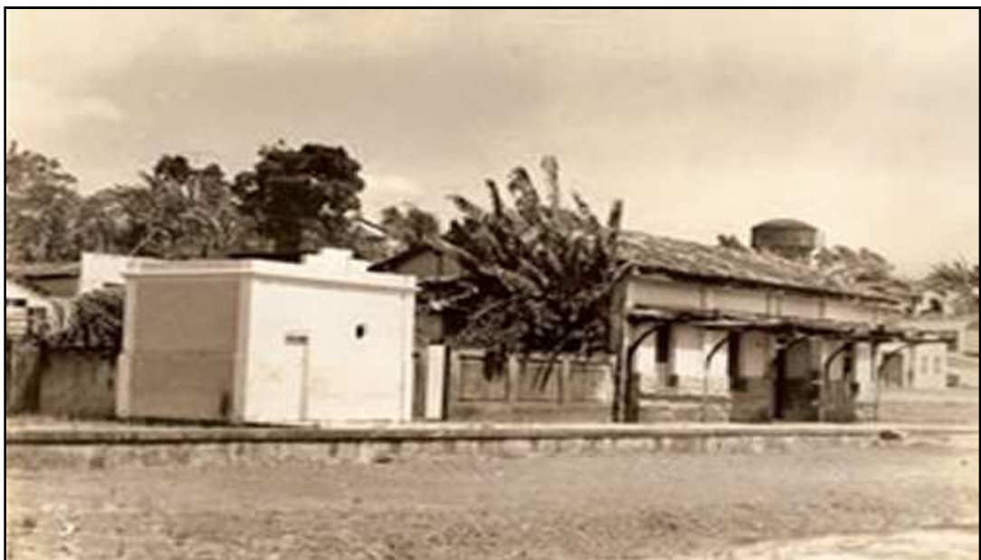
Figura 03: antiga estação da ferrovia de Borborema-PB
