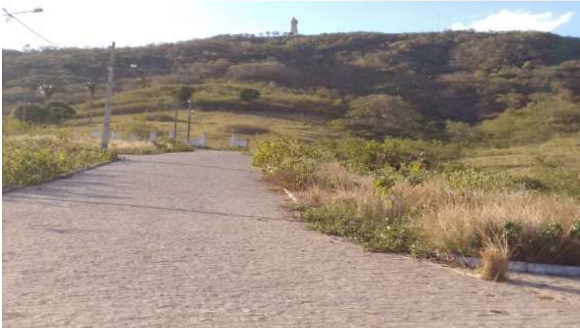
Figura 12 – Logradouro principal do loteamento Sol Nascente período 2016.
